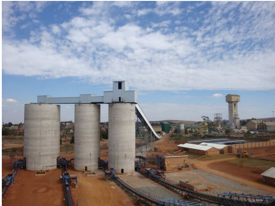
Mine souterraine de Ezulwini, Afrique du Sud
